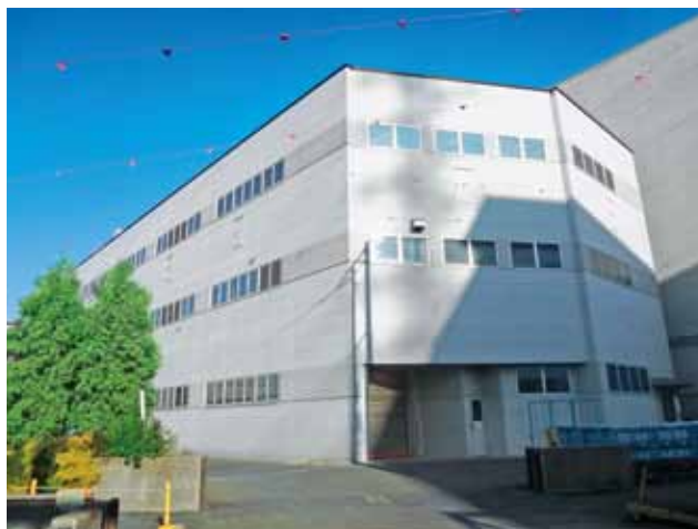
◆再資源化センター
